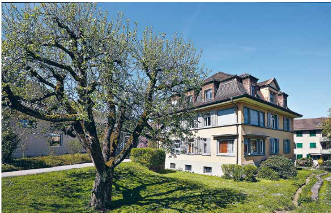
In der Villa entstehen Büroräumlichkeiten für die Mitarbeitenden der BGS. Foto: Iris Stutz.
