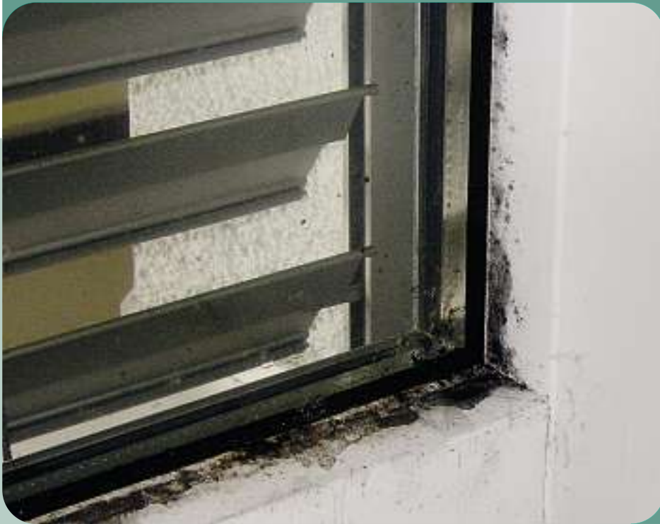
Schimmelbildung durch schlechte Lüftung.
